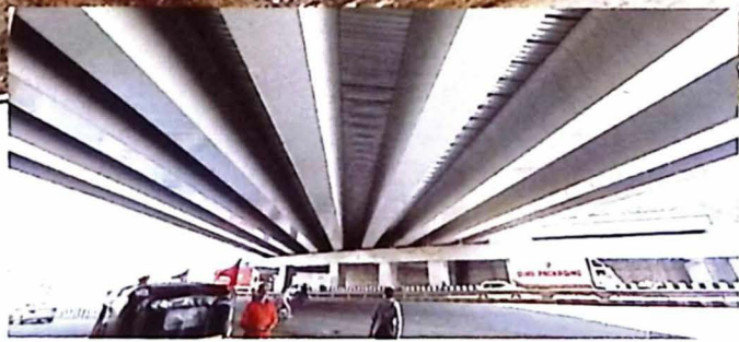
Dầm UHPC nhịp 55 m do Công ty Dura, Malaysia chế tạo.
