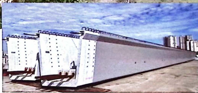
Cầu cạn sử dụng dầm UHPC nhịp lớn do Công ty Dura (Malaysia) xây dựng.
