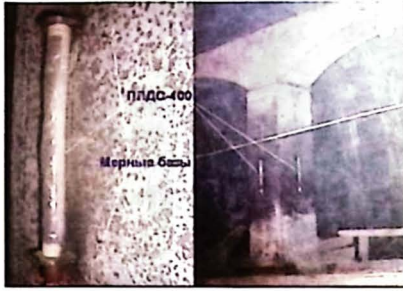
Hình 1. Vị trí đặt các tem điện trở quan trắc kết cấu cột chống ga hầm Metro [4].
