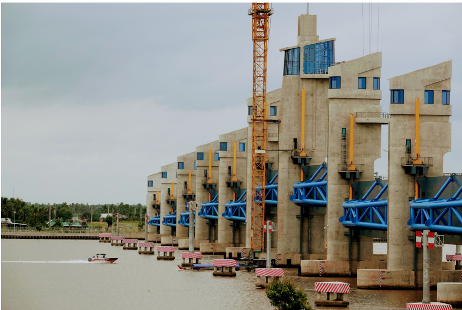
Chính phủ chú trọng xây dựng các công trình cống ngăn mặn giúp ĐBSCL ứng phó với biến đổi khí hậu.
