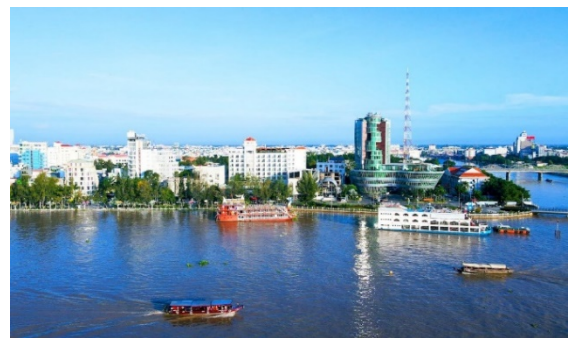
Xây dựng quận Ninh Kiều là đô thị mang đặc trưng vùng sông nước
