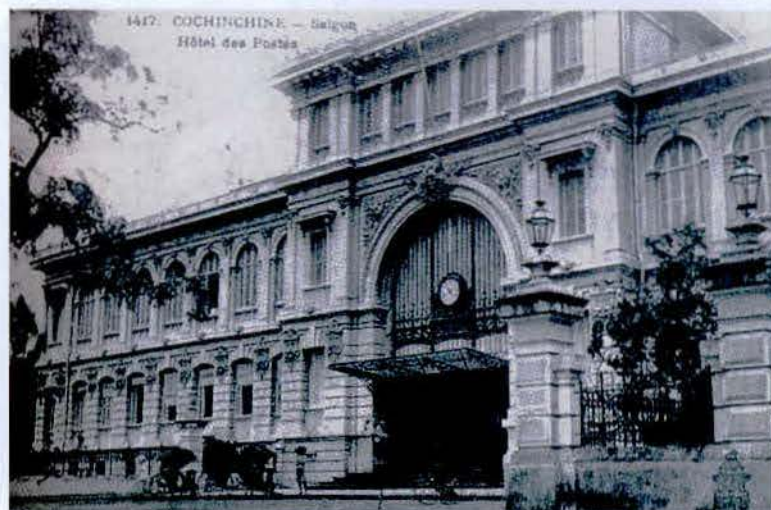
Tòa nhà Bưu điện TPHCM
