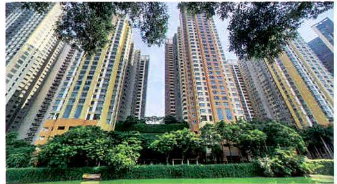
Hình 4: Tòa nhà chung cư cao tầng Mulberry Lane (Hà Nội) với không gian tầng trệt và tầng mái khối để có diện tích bố trí tiểu cảnh cây xanh, không gian vui chơi, bể bơi, luyện tập thể thao, tượng điêu khắc trang trí đặc sắc, được Singapore cấp giấy chứng nhận "Tòa nhà đạt tiêu chuẩn thân thiện với môi trường" BCA Green Mark năm 2014 (nguồn: tác giả)
