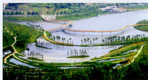
Kiến tạo hệ thống ao hồ thông qua các vùng ngập nước với mục đích làm chậm và thanh lọc nước mặt
