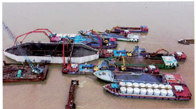
Hệ thống 03 hệ thống trạm trộn cấp 2.000 m 3 bê tông cho bộ trụ cầu Mỹ Thuận 2 trong thời gian <10 h.
