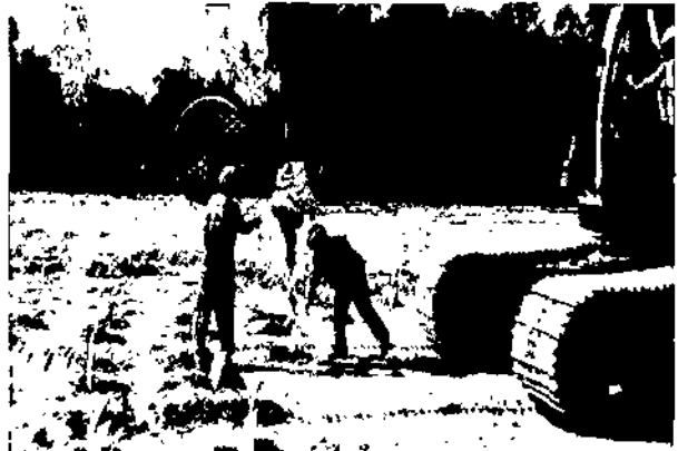
Hình 3- Phương pháp xử lý nền đất yếu bằng bắc thẳm
