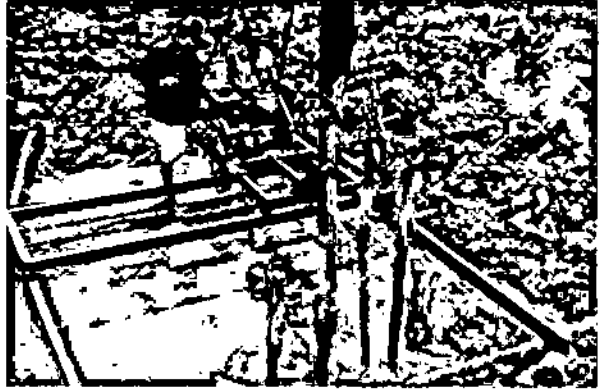
Hình 7- Đóng củ tràm dàn tự chế
