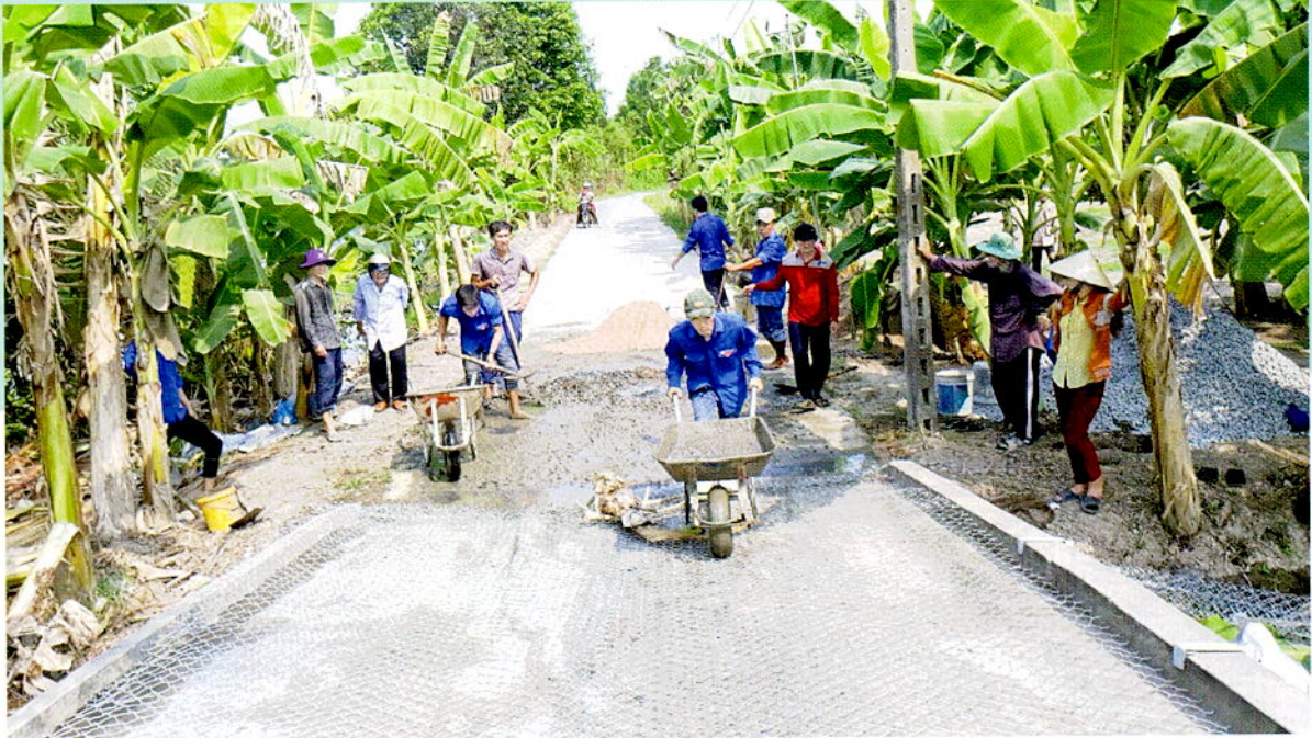
Tuổi trẻ quận Ô Môn xây cầu tại khu vực Tân Hưng phường Trường Lạc. Ảnh: QĐÔM.
