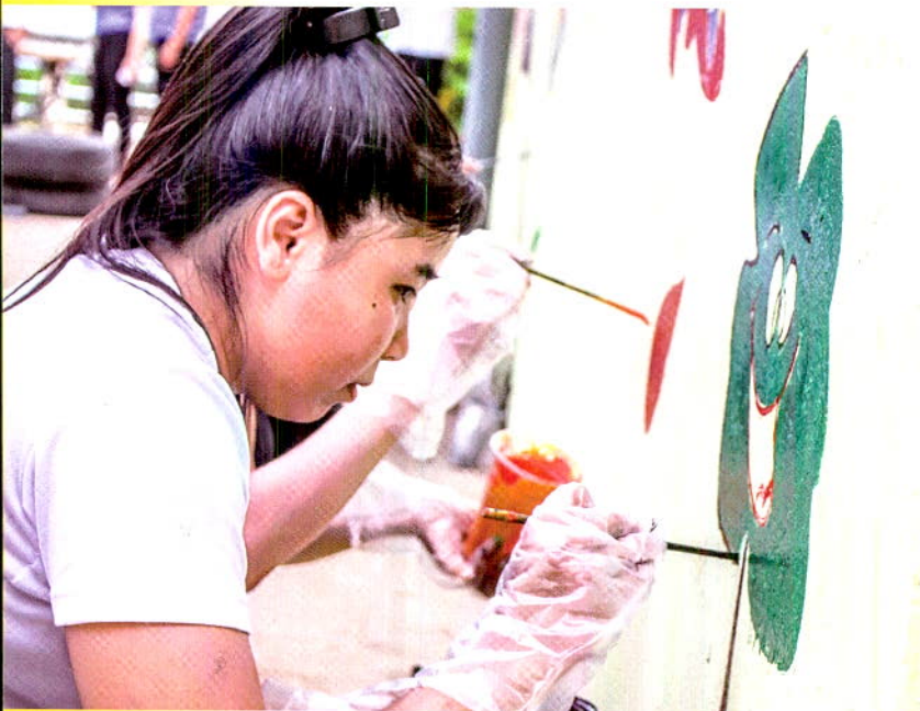
Dưới trời nắng gắt chiến sĩ tình nguyện Trường Đại học Kỹ thuật Công nghệ - Kỹ thuật Cần Thơ vẫn tâm huyết thực hiện công trình Khu vui chơi trẻ em tại phường Thới An Đông, quận Bình Thủy, thành phố Cần Thơ. Ảnh: THANH XUÂN
