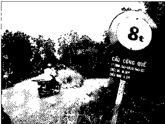
Hình 3: Cầu Cống Quế [Huế], xã Mỹ Hạnh Đông, huyện Cai Lậy, Tiền Giang. Ảnh: Lê Công Lý.
