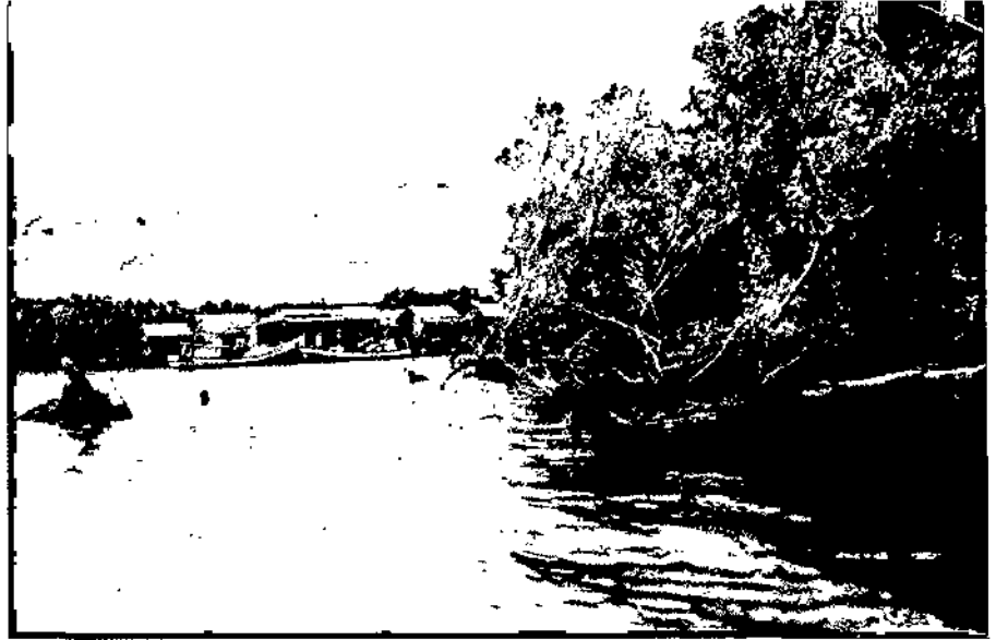
Một vạt rừng phòng hộ bị sóng đánh bật rễ thuộc địa phận ấp Sào Lưới, xã Nguyễn Việt Khái, huyện Phú Tân, Cà Mau.
