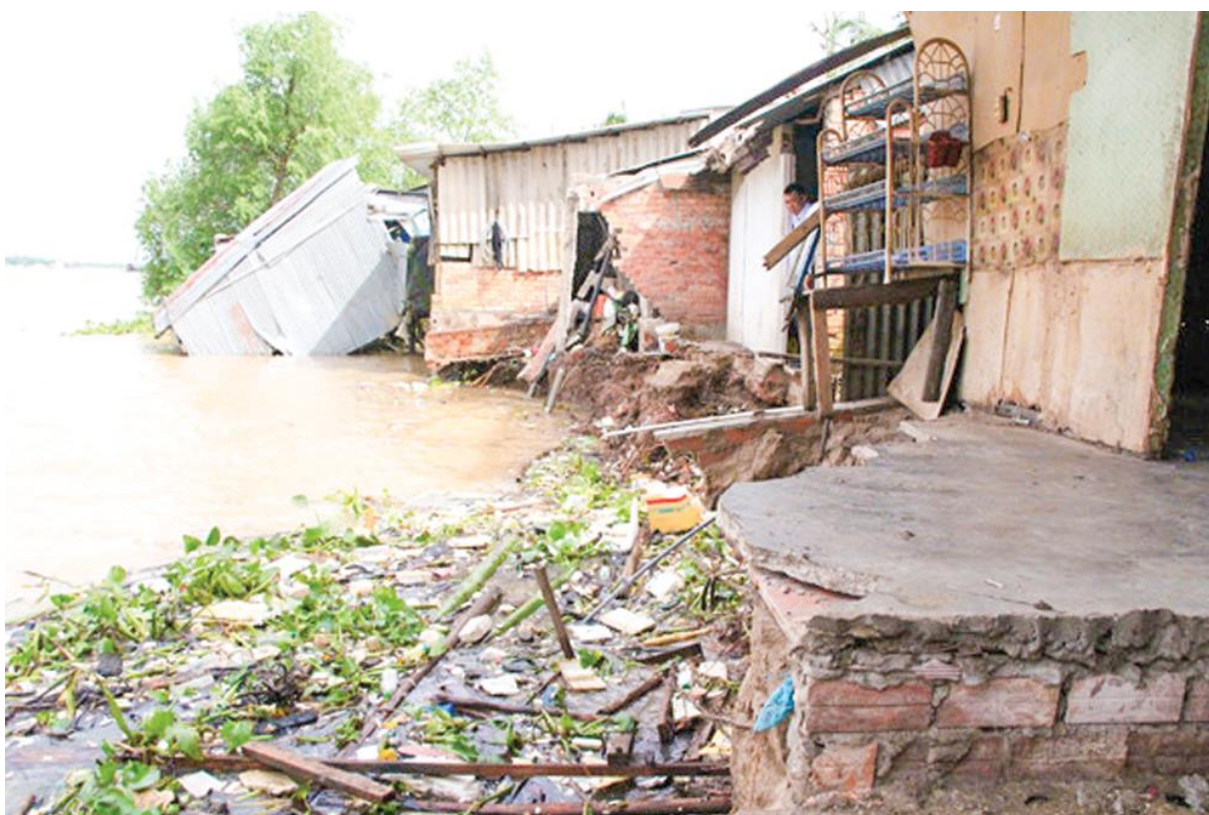
Bờ sông Hậu tại khu vực xã Mỹ Hòa, thị xã Bình Minh bị sạt lở nghiêm trọng do tình trạng khai thác cát bừa bãi. Ảnh: H.V
