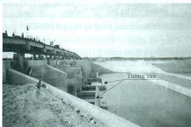
Hình 4. Ứng dụng kết quả nghiên cứu thí nghiệm tường van + lưới gà trong xây dựng cống ở ĐBSCL (cống Ba Lai tỉnh Bến Tre)
