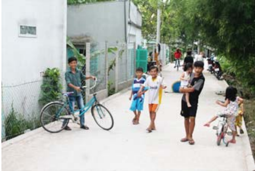
Một con hẻm ở phường Châu Văn Liêm, quận Ô Môn, TP Cần Thơ đã được đầu tư nâng cấp từ nguồn vốn của Dự án NCDT vùng ĐBSCL - Tiểu dự án TP Cần Thơ.
