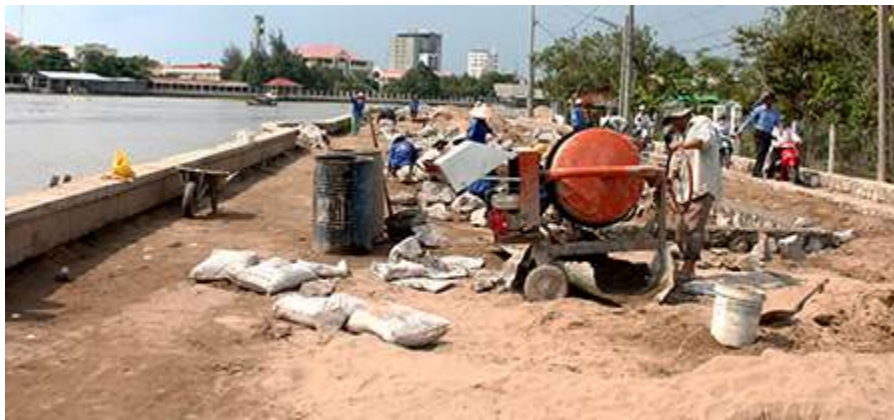
Thi công bờ kè sông Cần Thơ, phía bờ Cái Răng.
