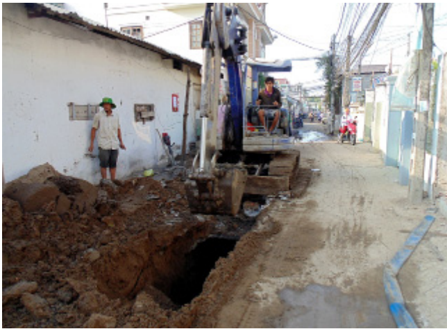
Thi công nâng cấp, mở rộng hẻm 51 đường 3 tháng 2 (thuộc Dự án nâng cấp đô thị vùng ĐBSCL - Tiểu Dự án TP Cần Thơ).
