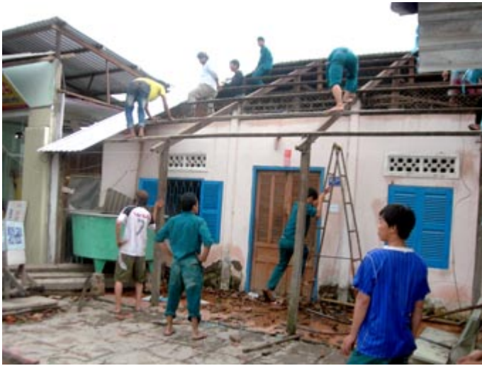
Lực lượng bộ đội, công an và dân phòng phường Bình Thủy, quận Bình Thủy tiếp người dân sửa chữa, lợp lại mái nhà bị tốc mái do thiên tai gây ra.
