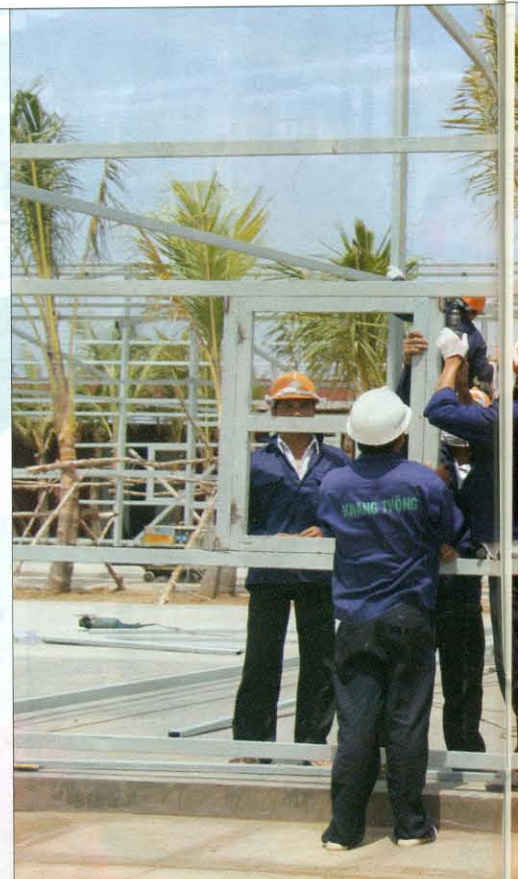
Công nhân xây dựng đang thi công công
